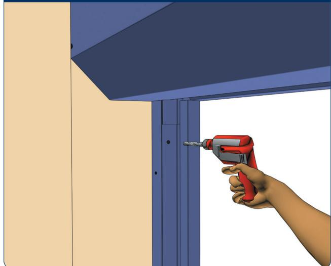
Просверлите отверстия для крепления каркаса противоподымной шторы к стене.
